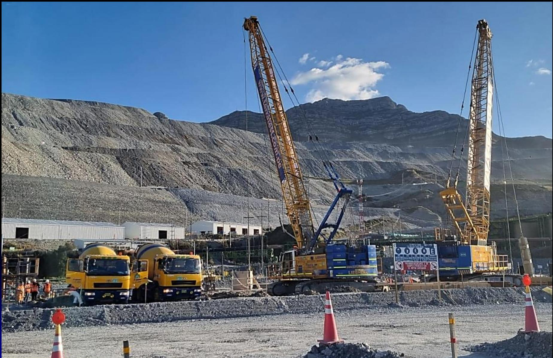
**Supervisión del proceso constructivo de muros impermeables de hormigón plástico moldeado in situ (Cut Off Wall).**
