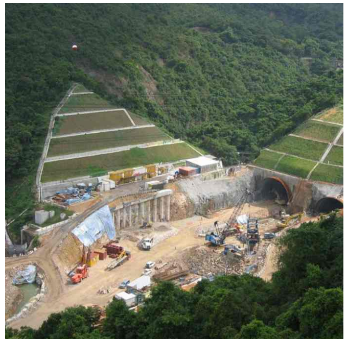
ESTUDIOS DE INGENIERÍA Suelos, agua, aire
